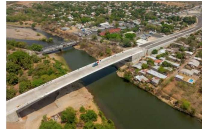
Imagen 1. Puente La Hachadura. Su construcción necesitó concreto de alta resistencia por la esbeltez de sus elementos, resistencias tempranas y durabilidad mejorada.
